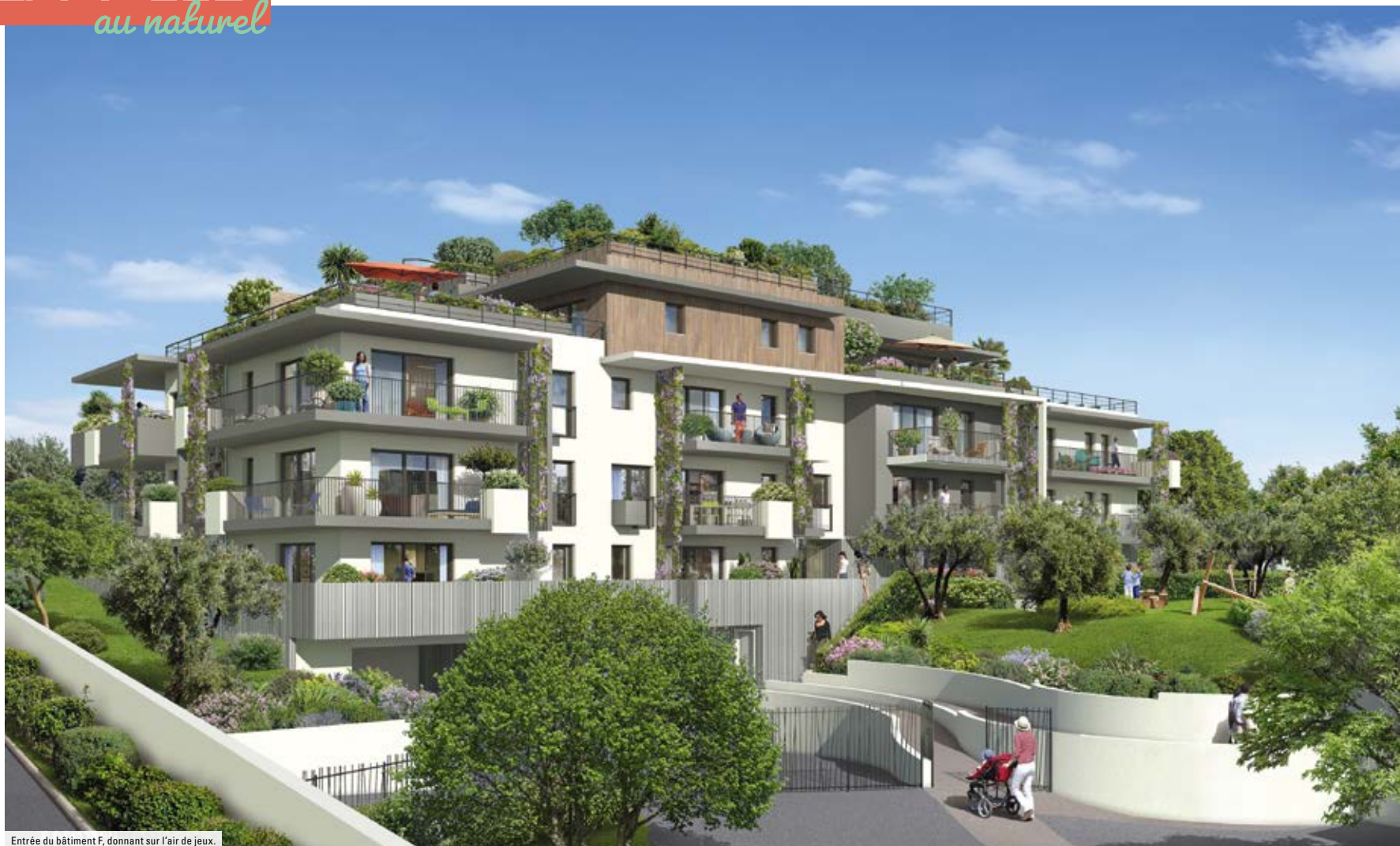
Entrée du bâtiment F, donnant sur l'air de jeux.
